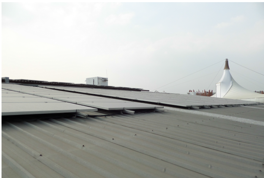
การติดตั้งแผงโซลาร์เซลล์ที่หลังคาโครงการพอร์โต้ ซิโน
